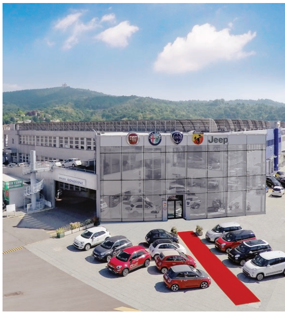
A destra, l'ingresso della grande sede di via Ala di Stura a Torino. Gli impianti sono alimentati da circa 8 mila metri quadrati di pannelli fotovoltaici posizionati sui tetti (producono circa 1 megawatt)
